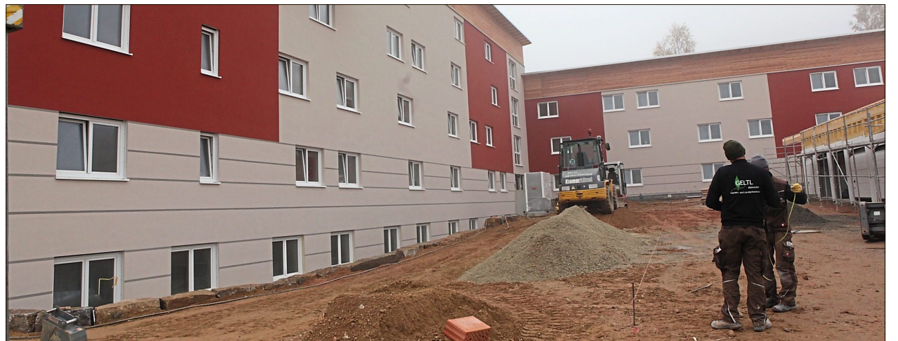
Die Arbeiten am ersten Bauabschnitt des Seniorengerechten Wohnens sind schon weit fortgeschritten. Im Dezember sollen die Wohnungen an die Käufer übergeben werden, ab 1. Februar sind sie bezugsfertig.
