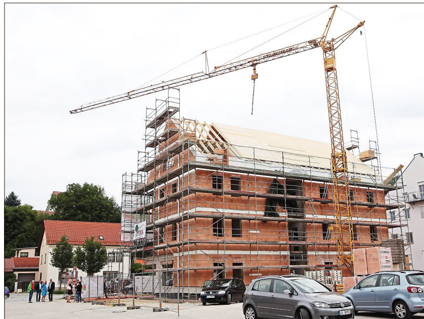
Der Rohbau steht und der Dachstuhl ist fast fertig: Der Projektaufakt für die „Alte Ziegelei“ diente auch als Richtfest für das Ärztehaus.
